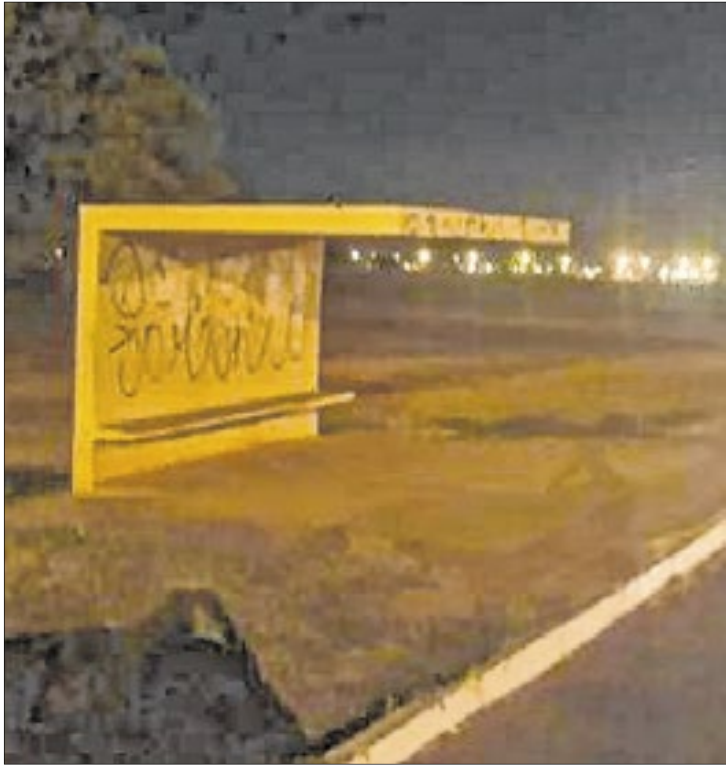
Paradas de ônibus sem iluminação são um problema
