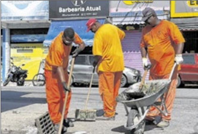
Serviço revitaliza vias e limpa sistemas de drenagem
