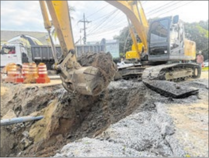
Escavações no cruzamento da Rua Padre Conrado com a Avenida Prefeito Alberto Lavinas foram temporariamente paralisadas
