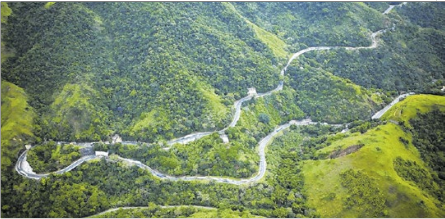
Apenas a pista de subida da Serra das Araras, na altura de Paracambi, será interditada durante a detonação de rochas
