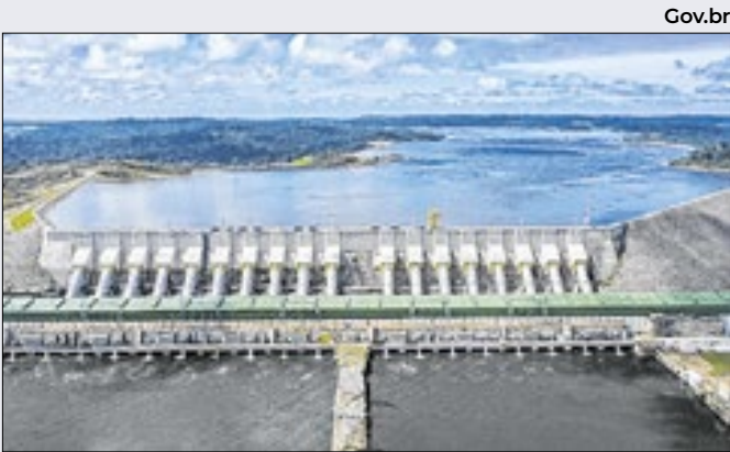
Boa condição de reservatórios não evitou alta tarifária
