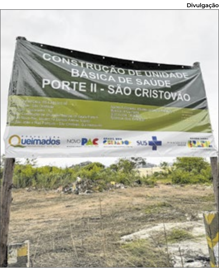
Início das obras da nova UBS foi autorizado em Queimados
