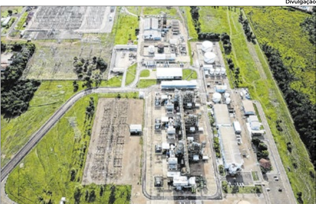
Outra termelétrica administrada pelo Termo Norte
