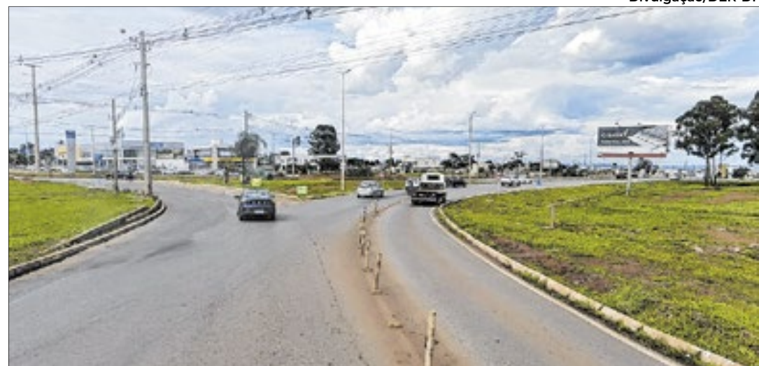
Divulgação/DER-DF O projeto prevê serviços de terraplenagem, locação, drenagem, pavimentação e implantação de ciclovia
