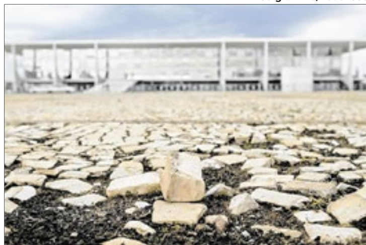
As pedras portuguesas, soltas, se tornaram "marca registrada" do abandono do espaço nobre da cidade
