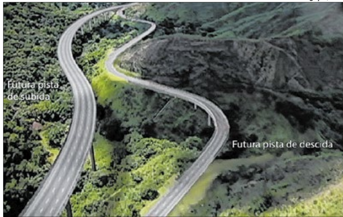
Obras completam um ano com 25% finalizada
