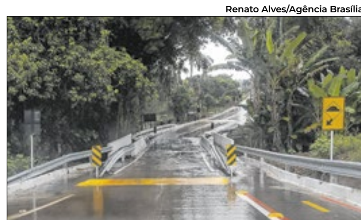
Projeto pavimenta acesso a escolas em áreas rurais
