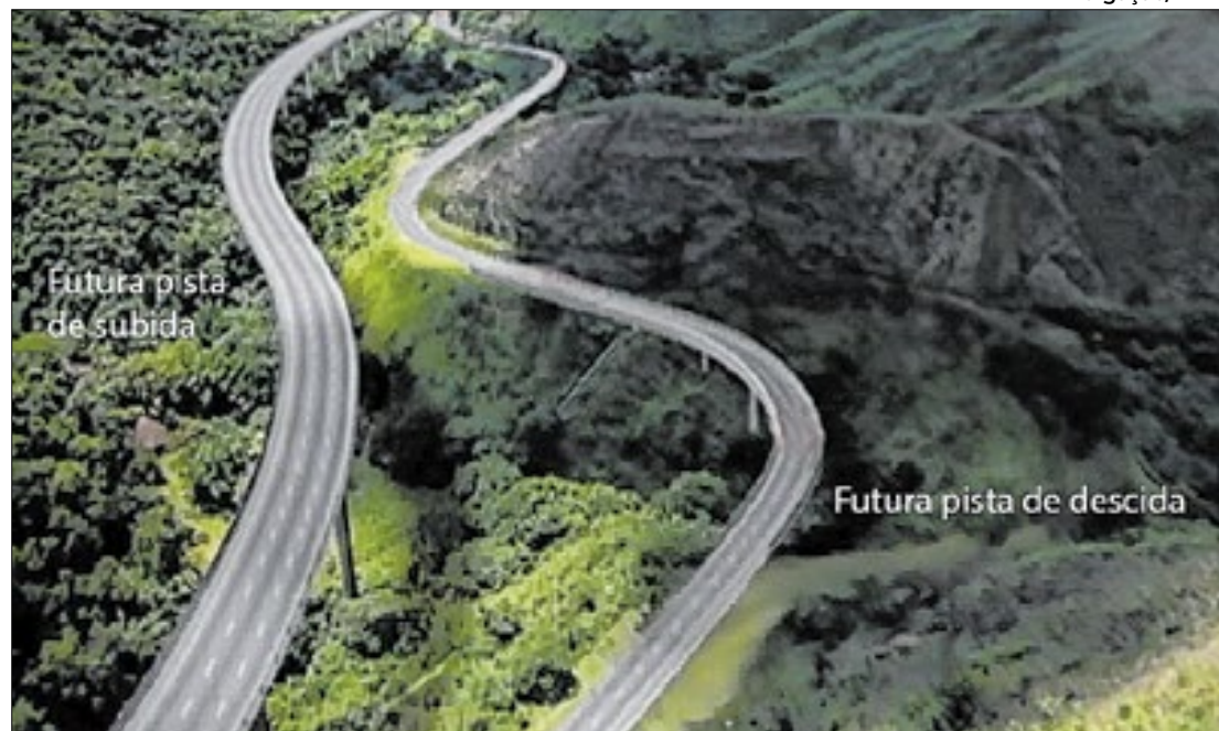
Obras na Via Dutra completam um ano com 25% de execução feitas pela CCR RioSP
