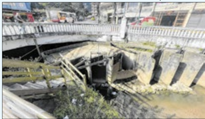
Túnel Extravasador em Petrópolis
