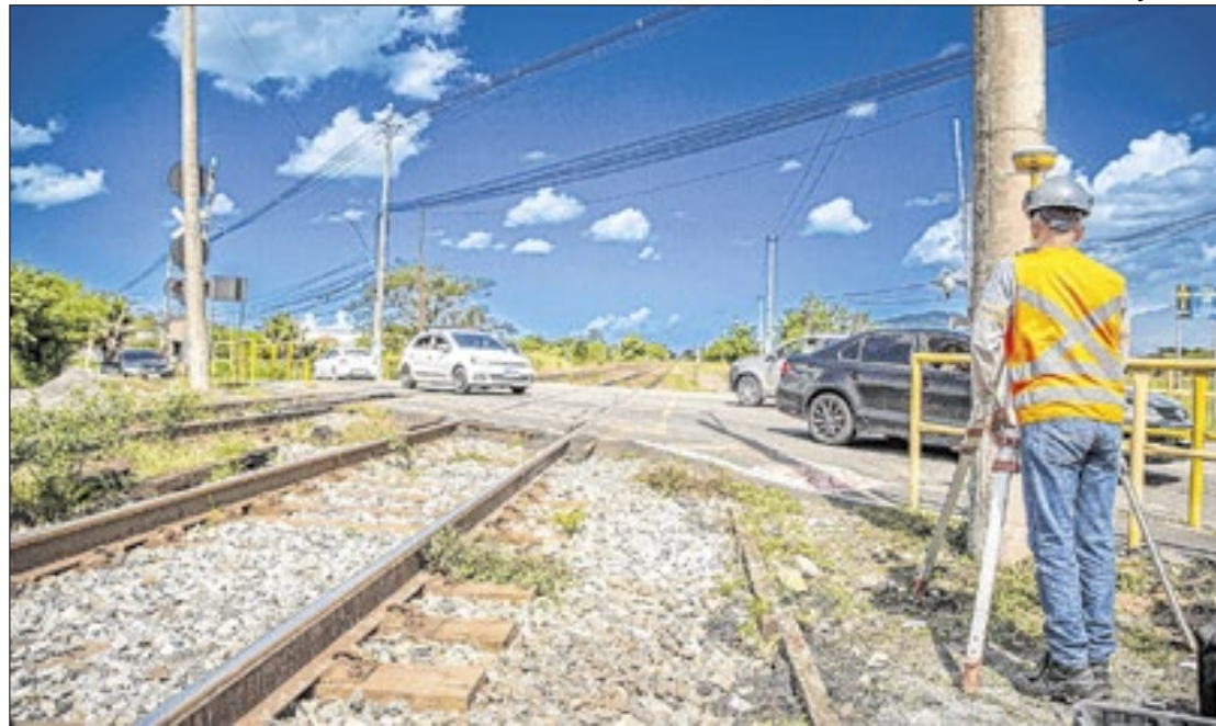
Técnico faz medição para elaboração de projeto do viaduto de Chaperó, em Itaguaí
