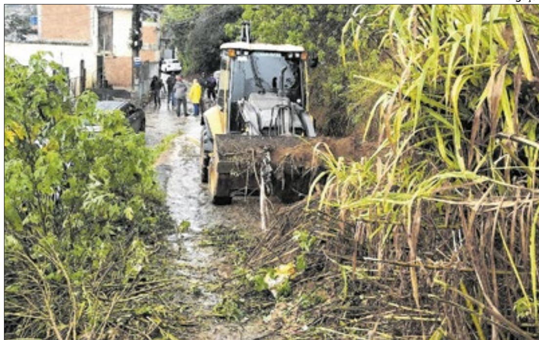
Equipes realizando a desobstrução de via pública na Rua Álvaro Paná, na Fonte Santa
