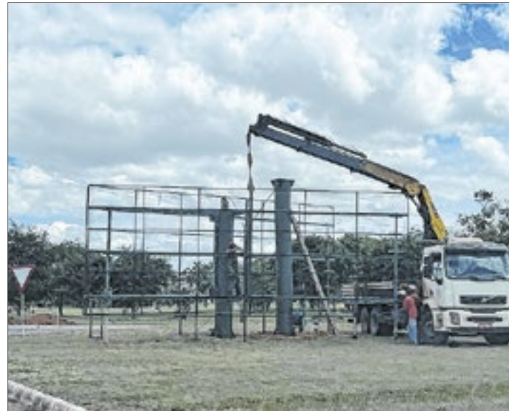
O caminhão começou a instalar os painéis na manhã de domingo, no Park Way
