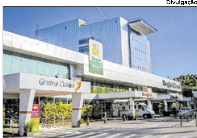
Unimed-VR está localizada na Rodovia dos Metalúrgicos
