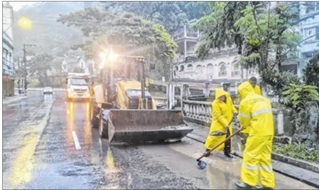
Equipes atuam na limpeza das vias
