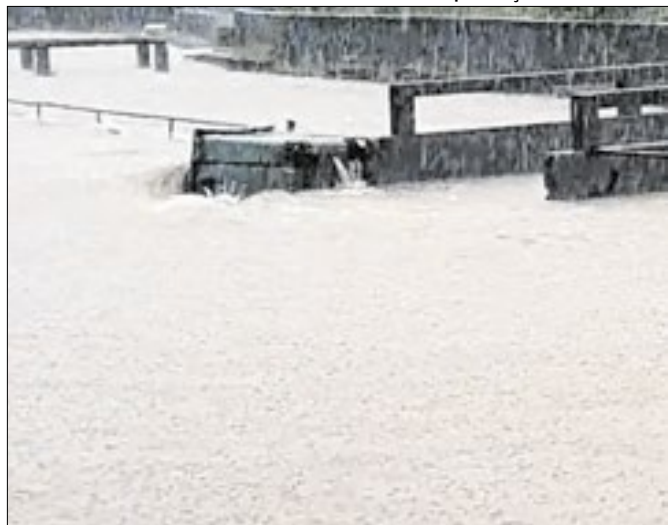
Alagamento na rua Coronel Veiga, durante a chuva
