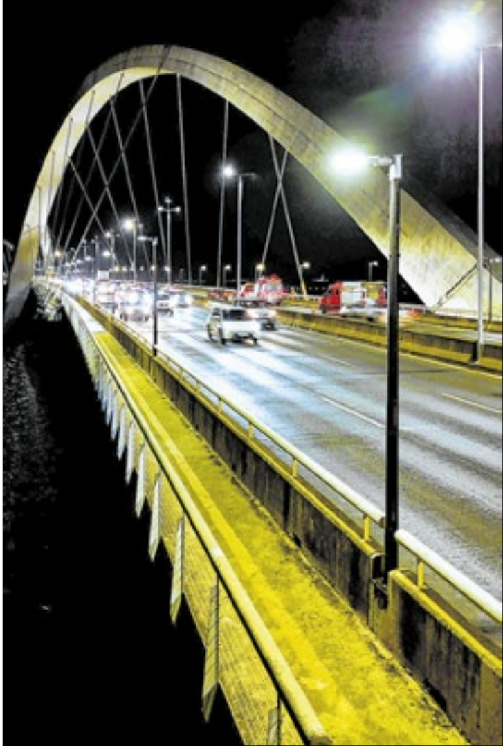
Nos serviços executados, foram utilizados quase 4 mil metros de cabo de alumínio em substituição aos de cobre
