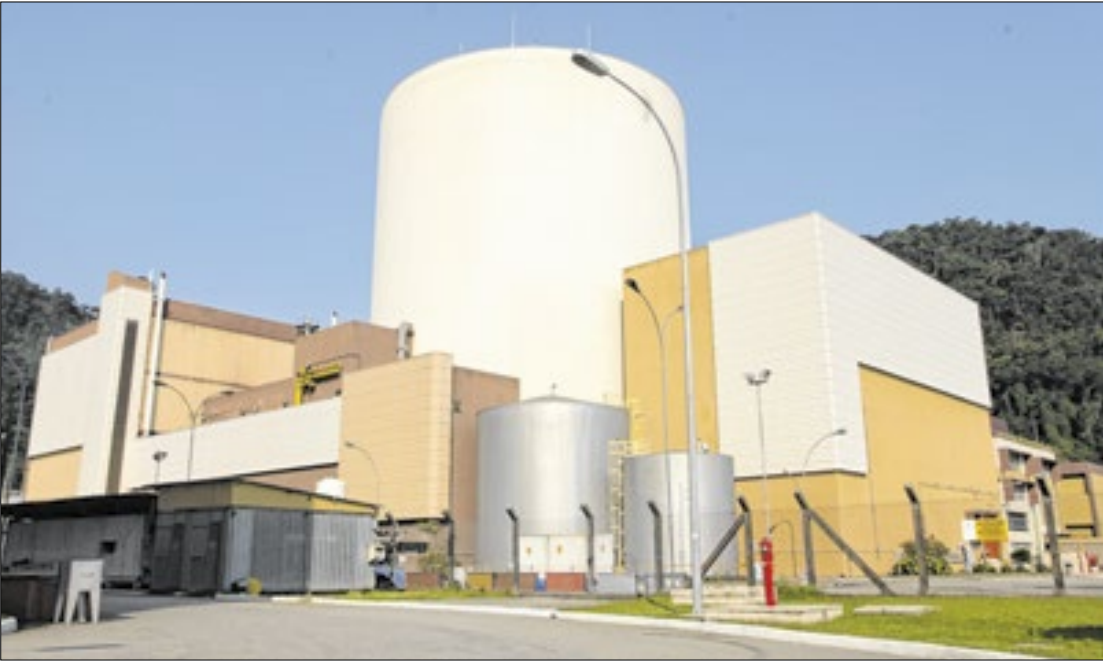
Desligamento faz parte do programa de segurança da usina
