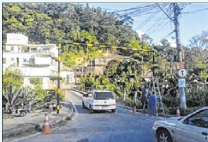
Limitadores foram instalados no local
