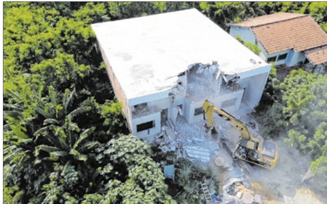
Demolições são um duro golpe à estrutura física do tráfico na Capital fluminense
