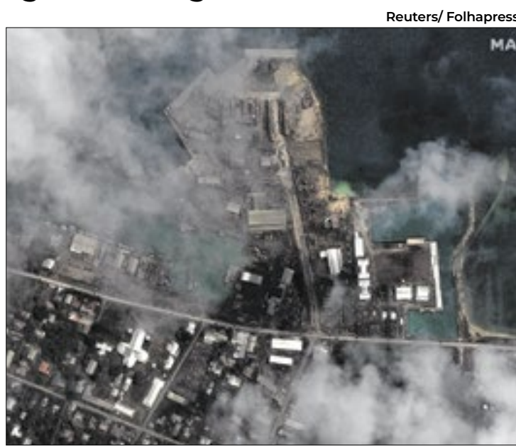
Tsunami afetou as instalações portuárias de Nucualofo
