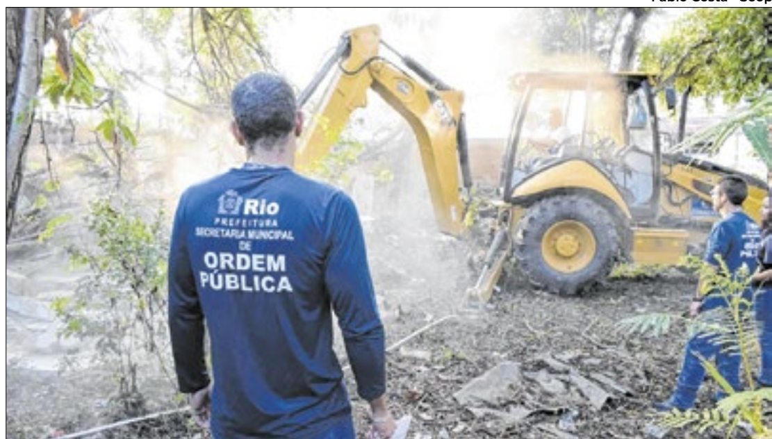
Demolição atingiu imóveis irregulares no entorno do Complexo Penitenciário de Bangu
