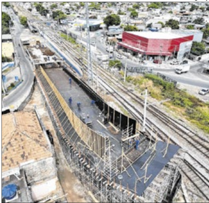
Viaduto está com obras em estágio avançado
