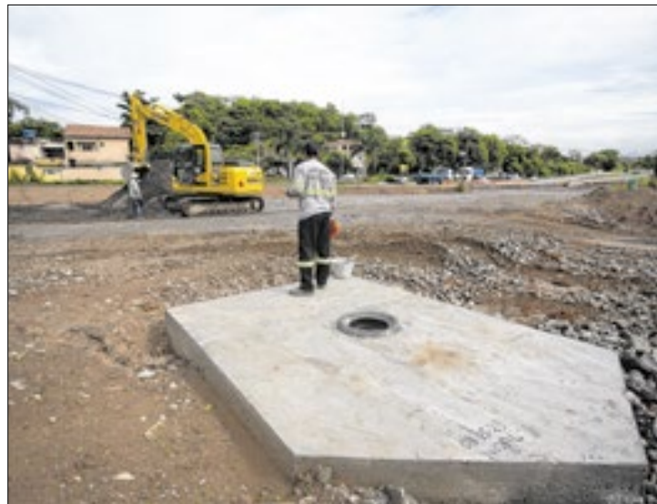
Obra na BR-393 já passou pelo processo de terraplanagem
