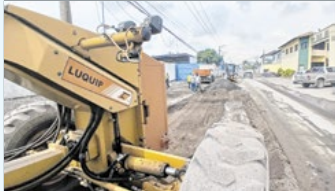
Via será completamente pavimentada em Barra Mansa
