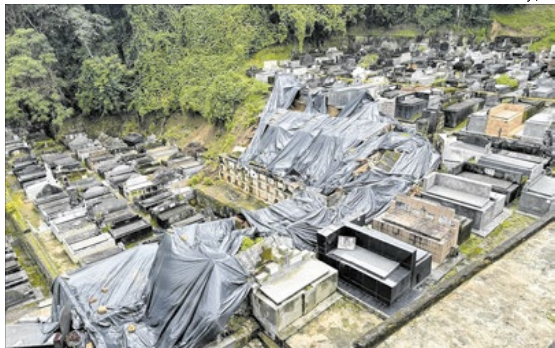
Deslizamento de 2024 levou abaixo centenas de gavetas e jazigos no Cemitério Municipal
