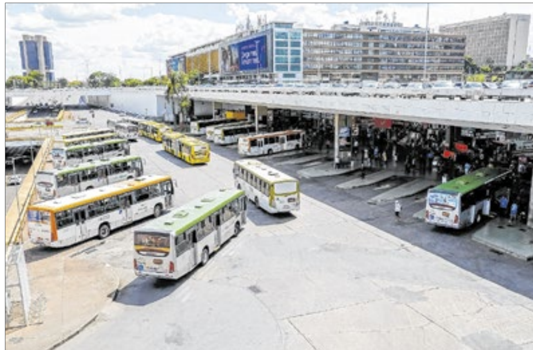
Rodoviária está em processo de privatização
