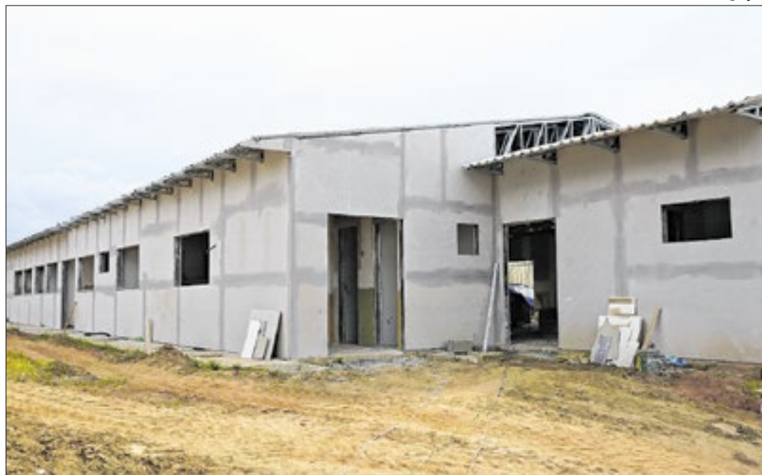
Estratégia de construção envolve o uso de steel frame no lugar das paredes de alvenaria
