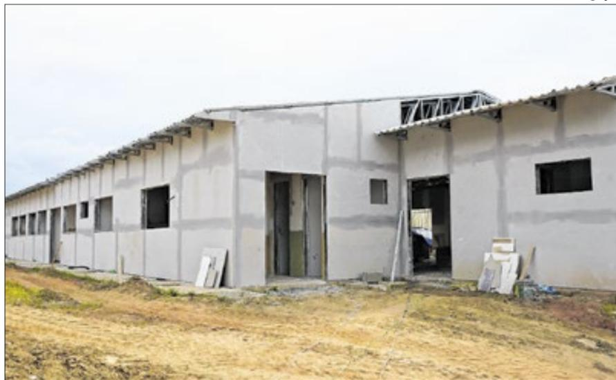
Estratégia de construção envolve o uso de steel frame no lugar das paredes de alvenaria
