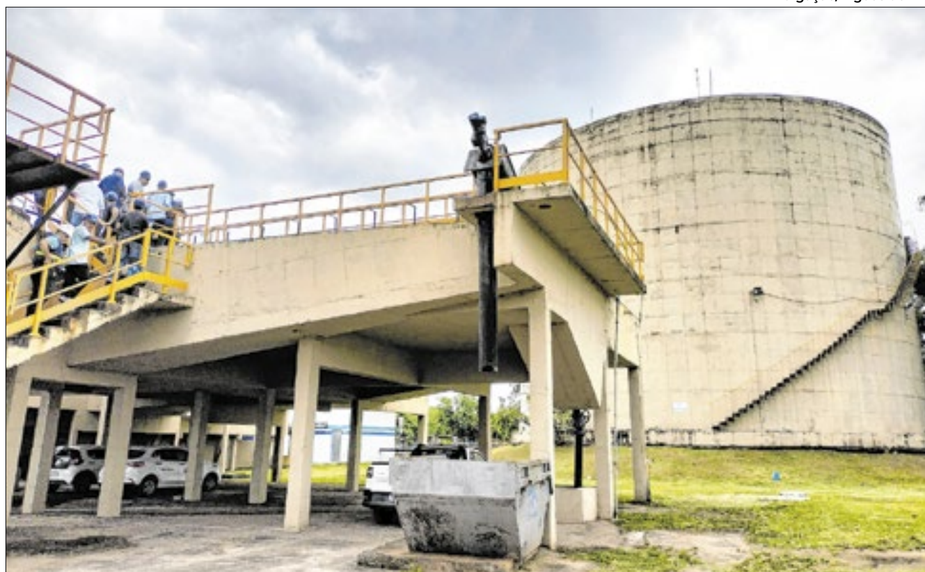
Sete milhões de litros de esgoto deixarão de cair por dia no Rio Alcântara
