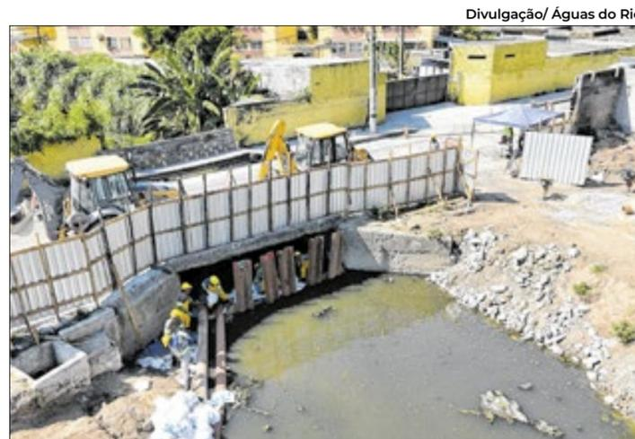
A captação de esgoto será feita nos rios Imboassú, Brandoas e Bomba, além de uma galeria pluvial na Rua Cônego Goulart
