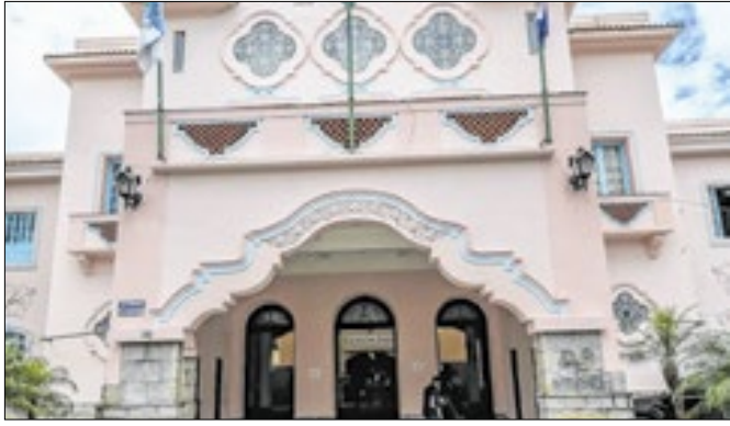
Material é para reforma da Escola Maçom Lino Oroña
