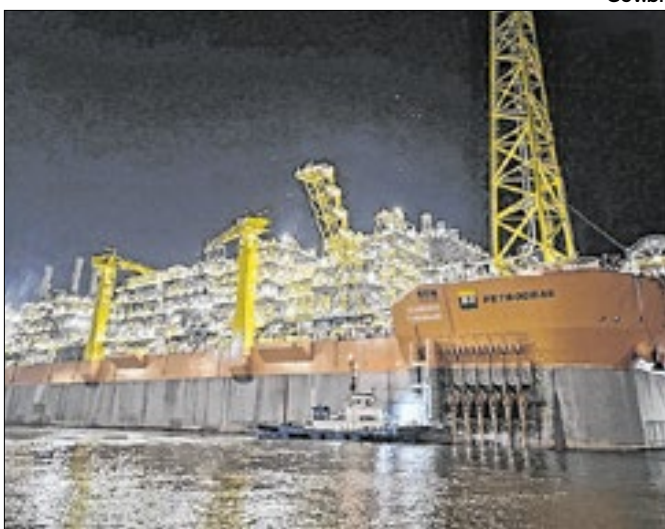
Campo de Búzios deve atingir 1 milhão de barris/dia
