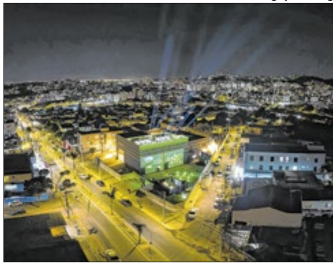
Cemig inaugurou 31 subestações e ampliou capacidade
