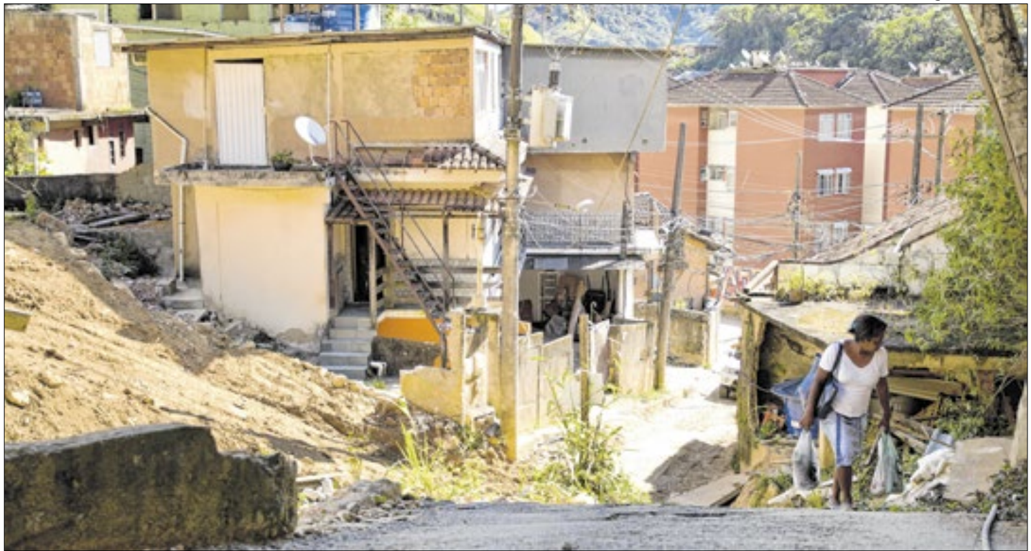
Embora o Morro da Oficina tenha sido o epicentro da tragédia, pessoas continuam morando ao redor da área colapsada
