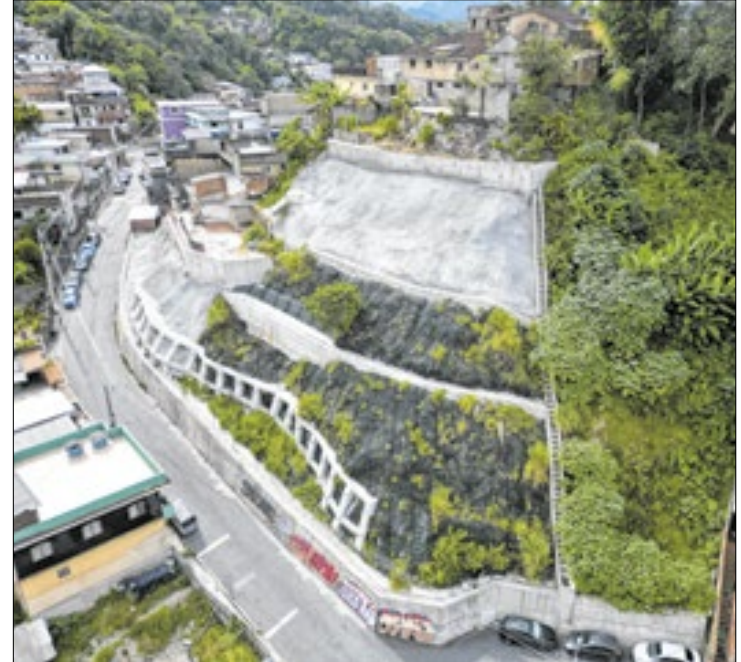
Obras de contenção foram realizadas no Chácara Flora
