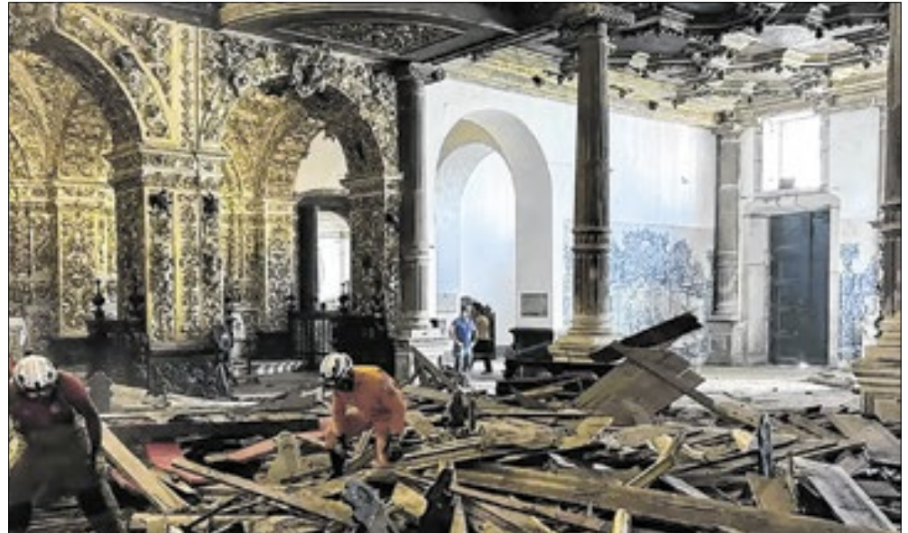
Teto da igreja depois do desabamento de parte do forro. Empresa detectou presença de cupins no local
