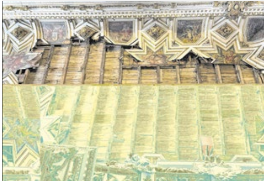
Teto da igreja depois do desabamento de parte do forro. Empresa detectou presença de cupins no local
