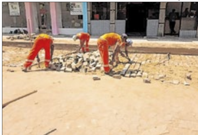
Reparo de paralelepípedos próximo à Rodoviária
