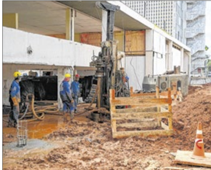
Para a CNI, aperto monetário impede o avanço da construção
