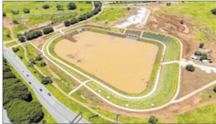
Primeira etapa do projeto começa a reduzir alagamentos
