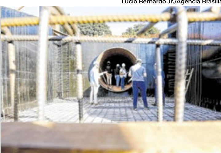
O projeto do Drenar-DF aproveita a rede antiga para duplicar a capacidade do sistema de drenagem
