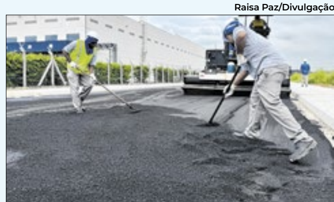
Melhorias na via de acesso à ponte do Pilar
