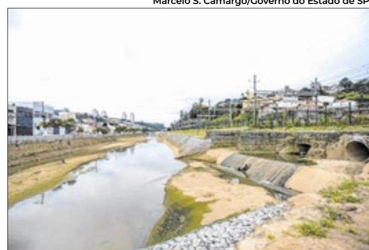
Reservatório teve investimento aproximado de R$ 54 milhões
