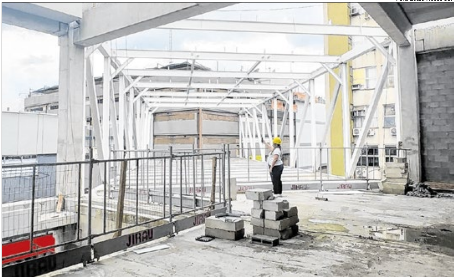
Estrutura da passarela do Sider Shopping, na Vila Santa Cecília, em Volta Redonda, está praticamente pronta
