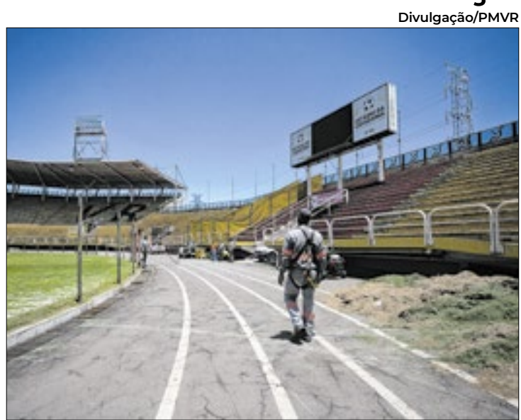
Novos refletores de Led instalados são mais eficientes
