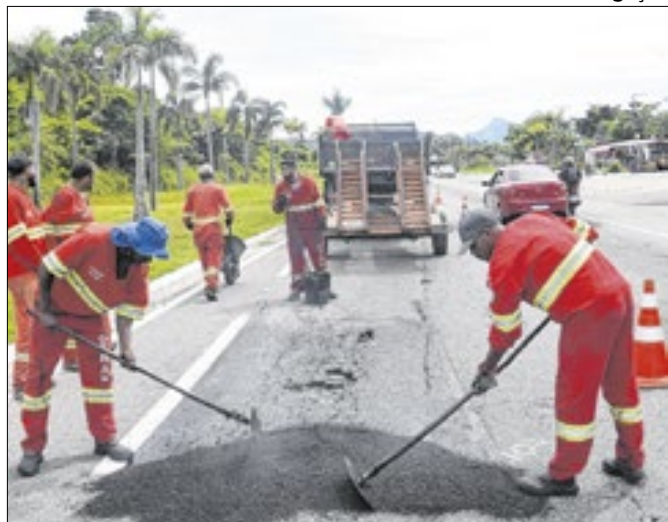
Foram recuperados cerca de 10 km de asfalto
