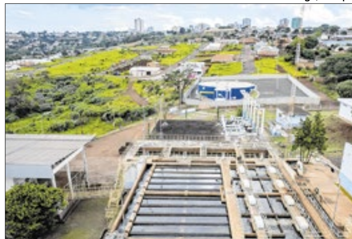
Região tem 61 empreendimentos de água e esgoto
