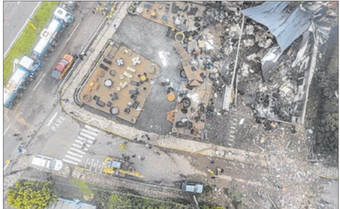
Aeronave atingiu estrutura de prédio em obras e caiu sobre uma loja de móveis
