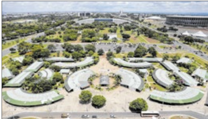
Obras visam melhorias estruturais e de acessibilidade
