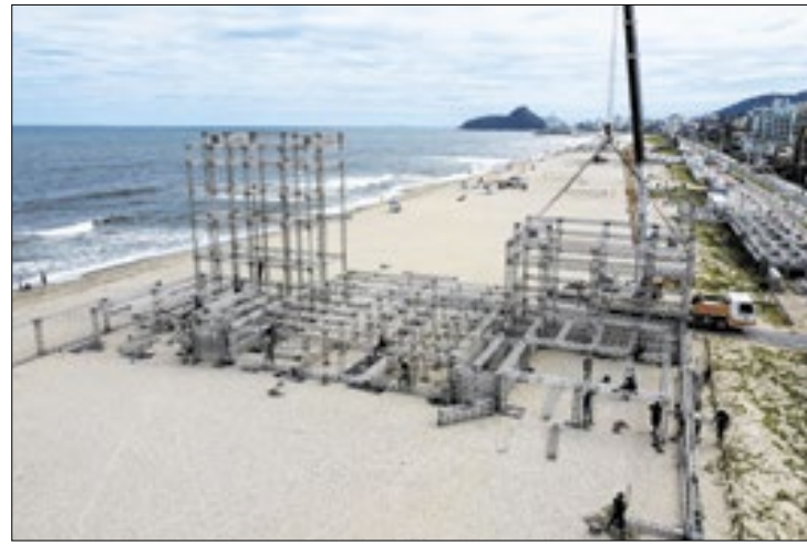
Estruturas estão sendo montadas em Matinhos e Pontal
