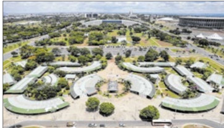
Obras visam melhorias estruturais e de acessibilidade
