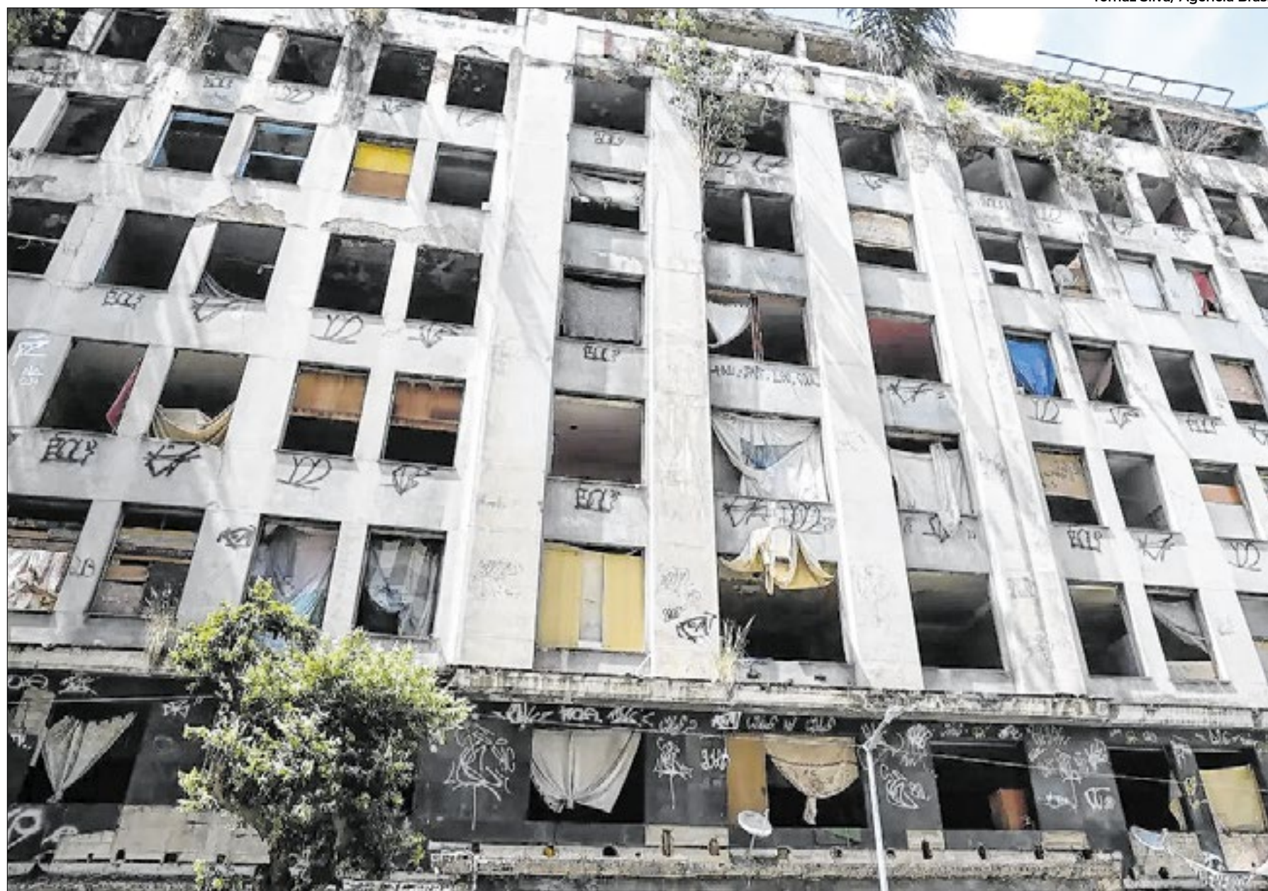
Prédio oferece riscos às famílias devido situação estrutural
